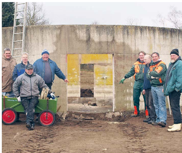
Schließlich klappt's: Das große Betonteil gibt nach.
